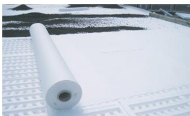
I filtri **DAKU STABILFILTER** sono geotessili realizzati con fibre di polipropilene e sono utilizzati come strato di separazione tra i pannelli **DAKU FSD** e il substrato **DAKU ROOF SOIL**.
