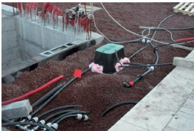
Figura 10 - Impianto di irrigazione in fase in installazione
